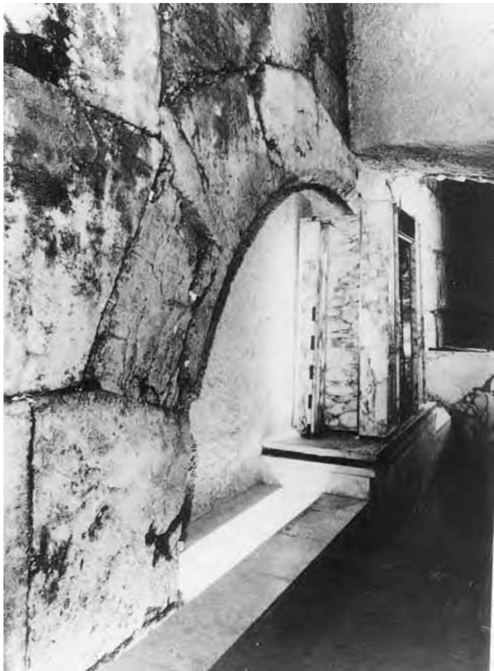
صورة لأحد الاقواس الموجودة عبر خط النفق وهذه الاقواس والاعمده هي التي تحمل الساحة بمنطقة المسجد الأقصى بعد حفرية دان بهاط
